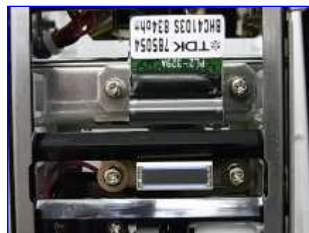
清掃後(正常な状態)
